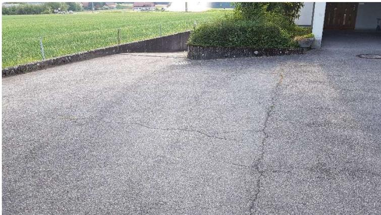
Die Entwässerung der Zufahrt erfolgt durch ein einseitiges Quergefälle in die bestehenden Rabatten resp. auf das Nachbargrundstück sichergestellt. Im Bereich der Absenkung wird die Entwässerung via Querrinnen gewährleistet. Die Entwässerung erfolgt teilweise oberflächlich diffus, teilweise via Sickerschächte (nicht gestattet) und teilweise in die öffentliche Mischabwasserleitung (möglichst zu vermeiden).
