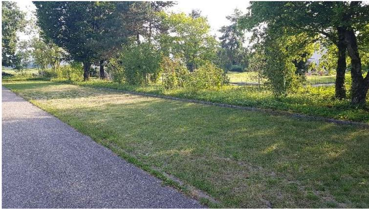
Die Fahrgasse besteht aus einem Belag mit einem Grösstkorn von 32 mm. Ein Deckbelag wurde nicht eingebaut. Das Regenwasser der Fahrgasse wird via Dach- und Längsgefälle in die bestehenden vier Ablaufschächte abgeleitet und wiederum in unterirdische Versickerungen (Sickerschächte) geleitet.
