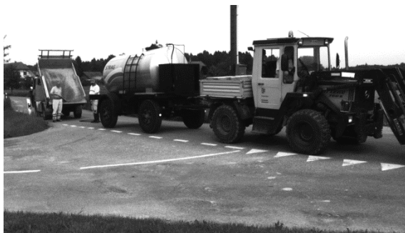
Das Vorflickern erfordert den Einsatz aller Werkhofmitarbeiter.
