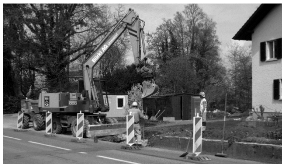
Abbrucharbeiten Gehwegbau Landshutstrasse.
