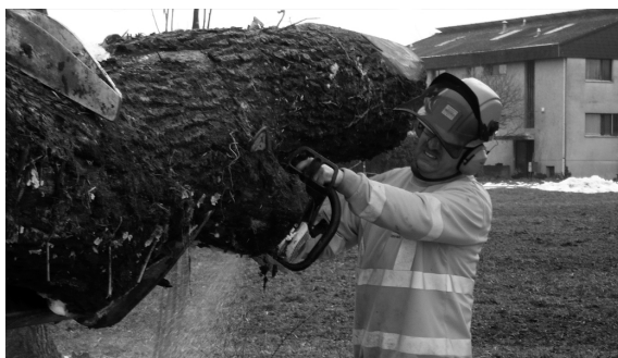
Ein Baumstamm wird für den Bachverbau vorbereitet.
