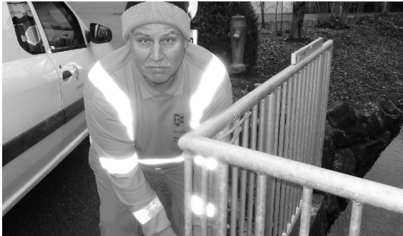
Hans-Rudolf Stuker beim Montieren von Geländern.
