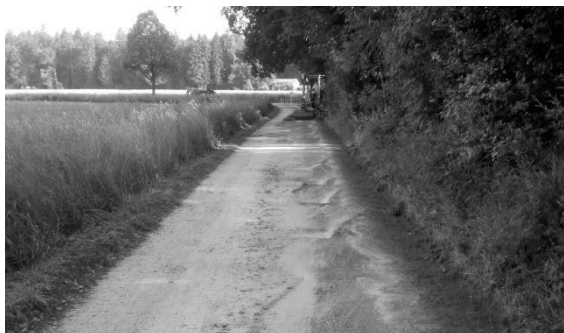
Abtragung Naturweg durch Bagger.
