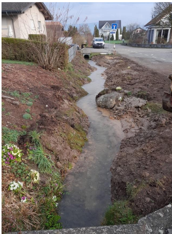
Grünibächli kurz nach den Bauarbeiten.
