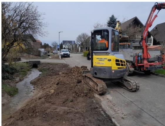
Baggerarbeiten Grünibächli im Bereich Feldeggstrasse.
