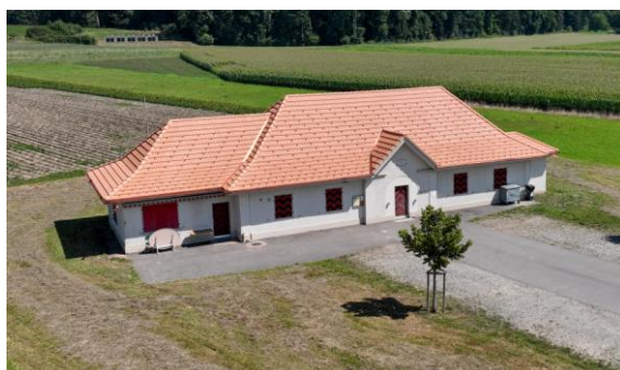
Erfolgreiche Dachsanierung Schützenhaus Rain 3.
