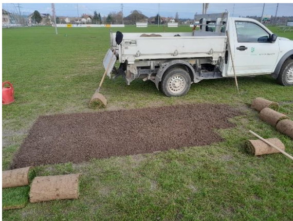
Verlegen von Rollrasen im Torraum.
