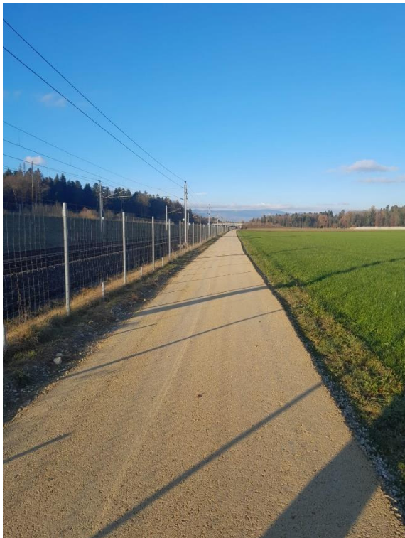
Flurweg östlich der SBB-Neubaustrecke kurz nach dem Unterhalt.
