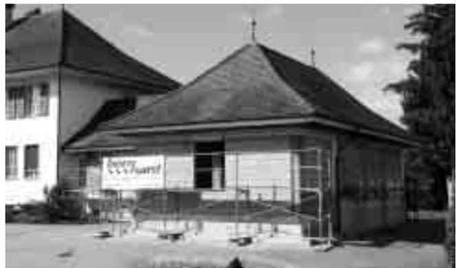
Diese von aussen gut sichtbaren Arbeiten wurden begleitet von Heizungs- und Sanitärarbeiten (Abhängen der Heizungen, Demontage der Wasserleitungen) sowie von Elektrikern, welche ebenfalls Abbrucharbeiten vornehmen und Provisorien installieren mussten. Kurz darauf begannen die Bau-
