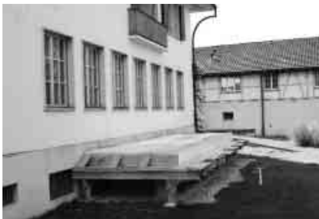
Rohbau der Erweiterung auf der Rückseite des Gemeindehauses
