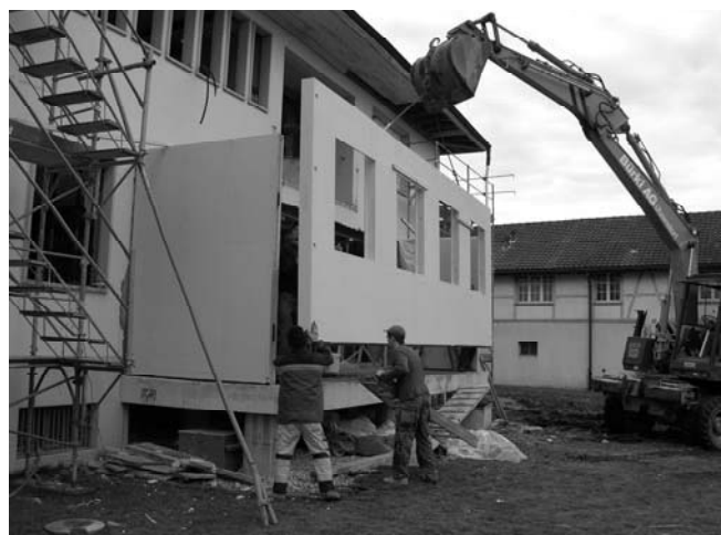
Erweiterung auf der Rückseite des Gemeindehauses
