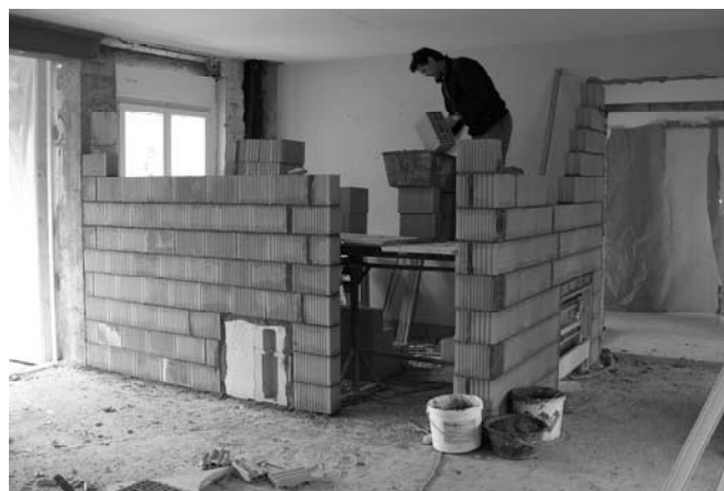
Aufmauern des Besprechungszimmers der Bauverwaltung
