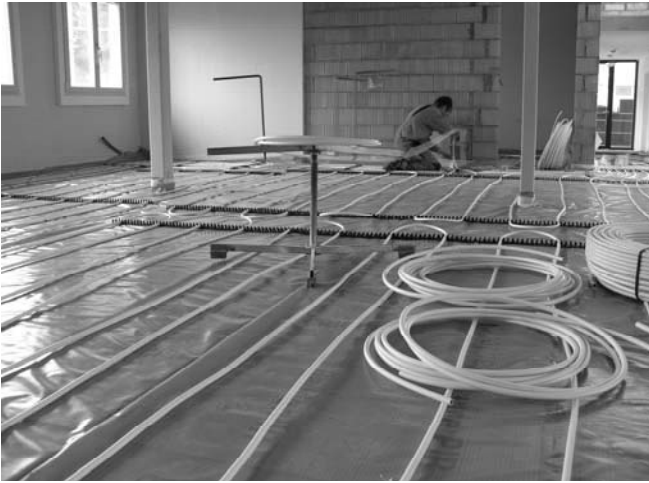
Verlegen der Bodenheizung
