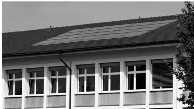
Die Kollektoranlage des Gotthelfschulhauses umfasst 45 m<sup>2</sup> und wird zur Warmwasseraufbereitung eingesetzt.
