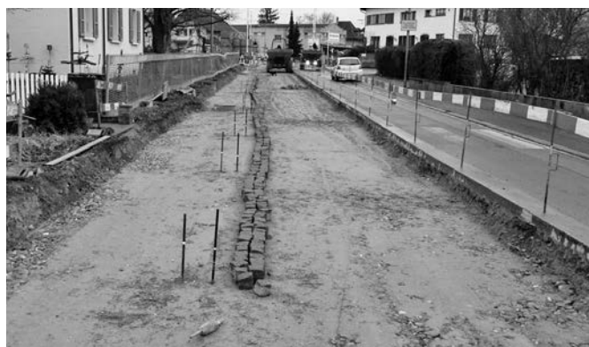
Die Bundsteine für den Randabschluss zwischen Landshutstrasse und Gehweg liegen bereit.
