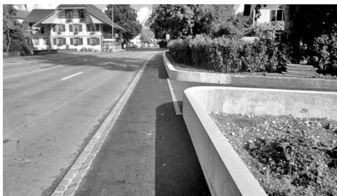
Beim östlichen Gehweg der Landshutstrasse sind die Randabschlüsse versetzt und die Tragschicht eingebaut.
