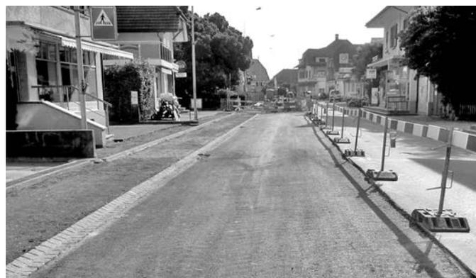
Bei der Poststrasse sind die Elektroleitungen und die Bachleitung im Gehweg eingebaut.
