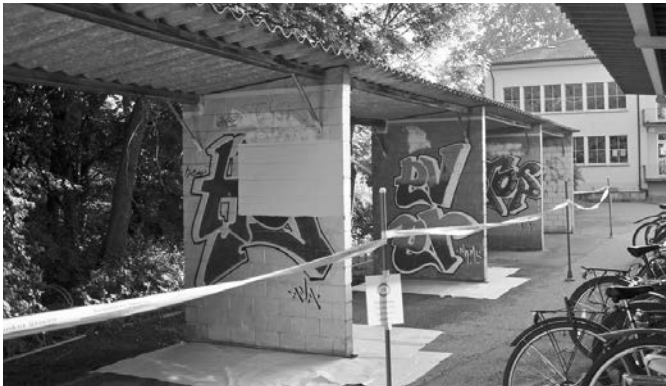
Die alten Wände werden neu übermalt. Neue Grundfarben werden drauf gemalt.
