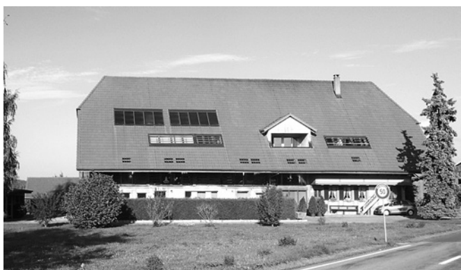
Umnutzung eines landwirtschaftlichen Gebäudes mit mehreren Wohneinheiten.
