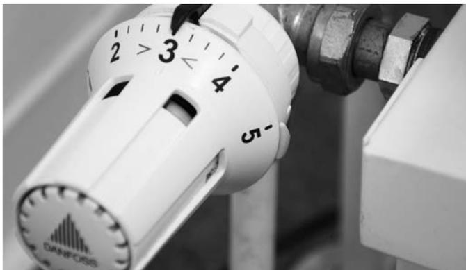
Thermostatventil zur Regelung der Raumtemperatur.
