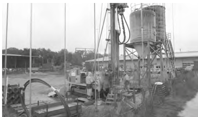
Letzte Überprüfungen des Bauplatzes für das neue Feuerwehrgebäude.
