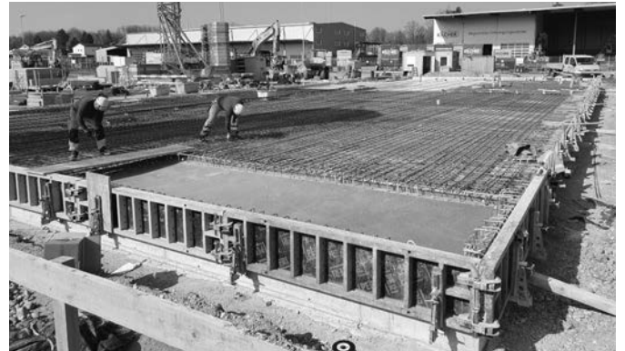
Bauarbeiten werden ausgeführt.
