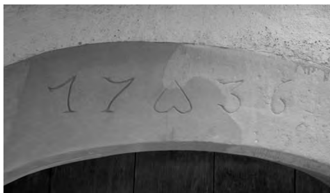
Restaurierter Sandstein mit Jahrzahl 1736, Eingang Keller.
