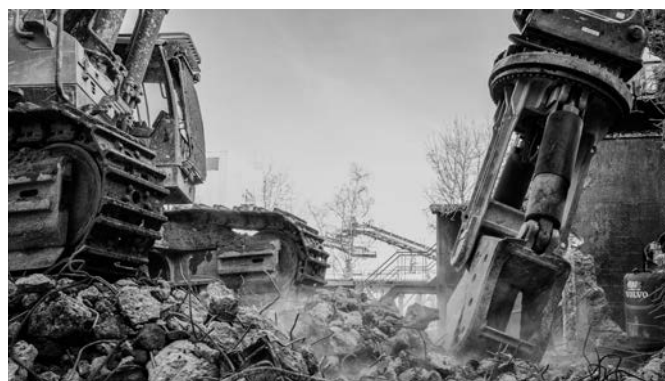
Bagger mit «Beisser» beim Zerkleinern von Eisenbeton.
