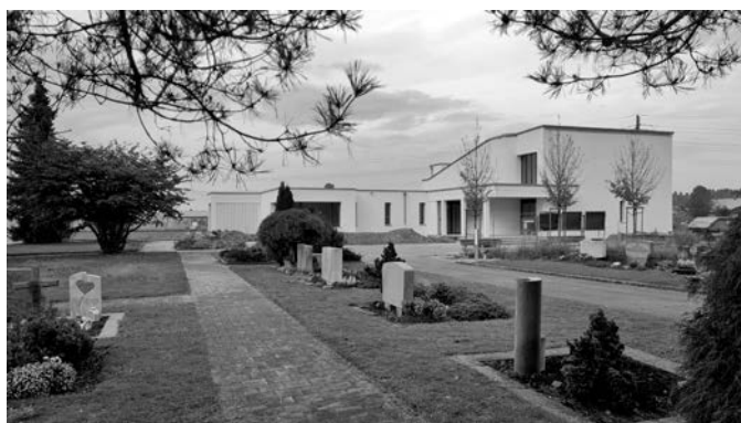
Endspurt für die Sanierung des Gebäudes.
