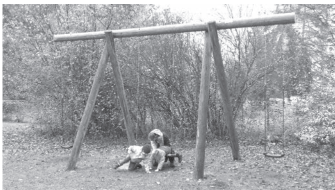
Sogleich wird das reparierte Schaukelgestell getestet.
