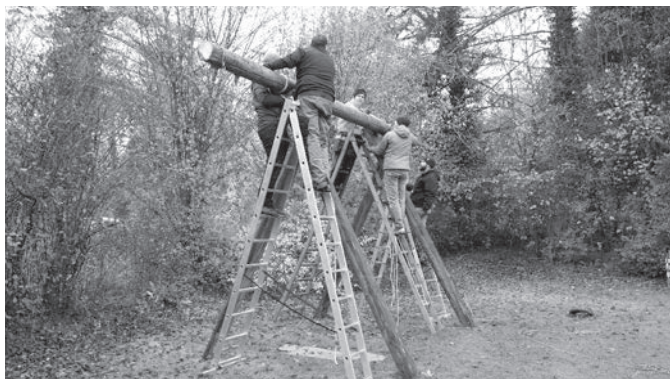
Mit vereinten Kräften wird der schwere Balken auf das bestehende Gestell gehoben.
