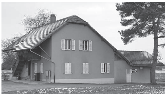
Liegenschaft Lindenstrasse 53 mit Kadaversammelstelle im Anbau rechts.
