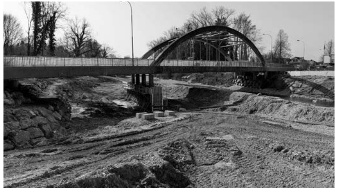
Aktuelle Sanierung Bätterkinden Brücke.
