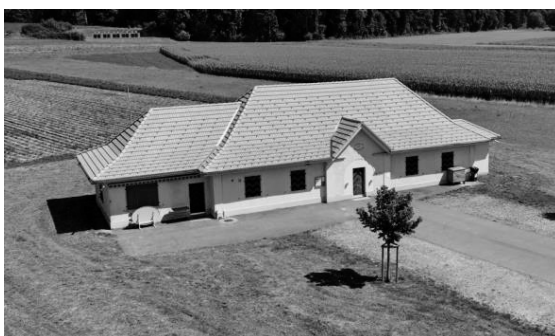
Erfolgreiche Dachsanierung Schützenhaus Rain 3.
