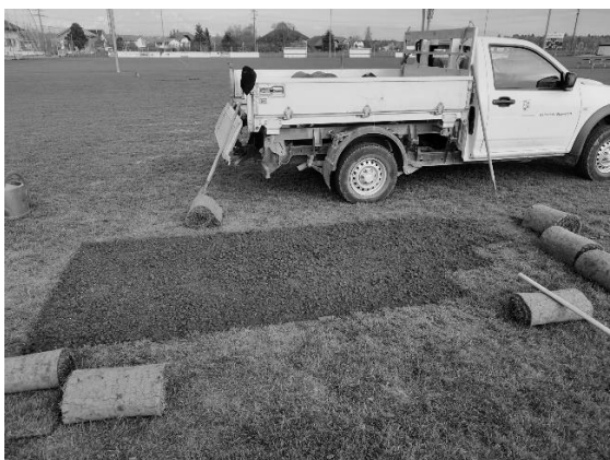
Verlegen von Rollrasen im Torraum.
