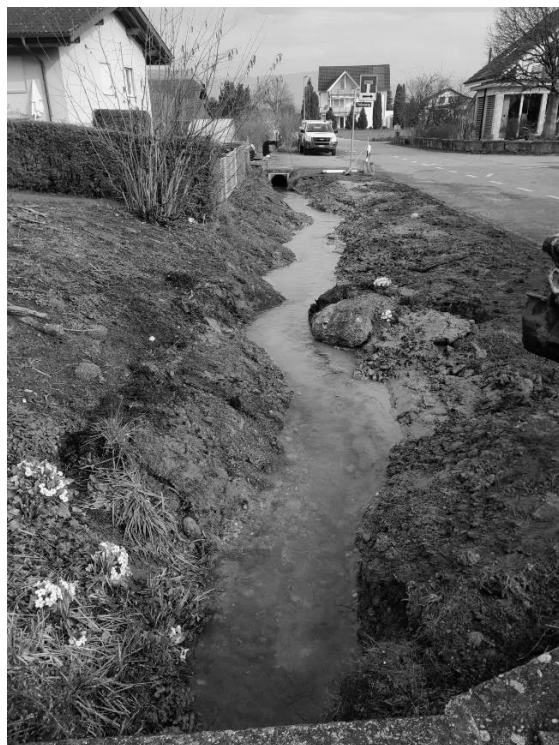
Grünibächli kurz nach den Bauarbeiten.
