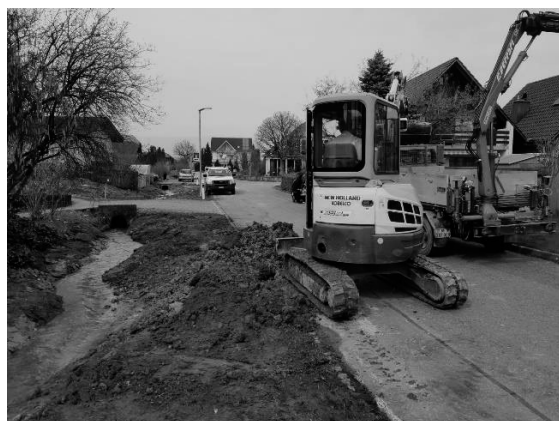
Baggerarbeiten Grünibächli im Bereich Feldeggstrasse.
