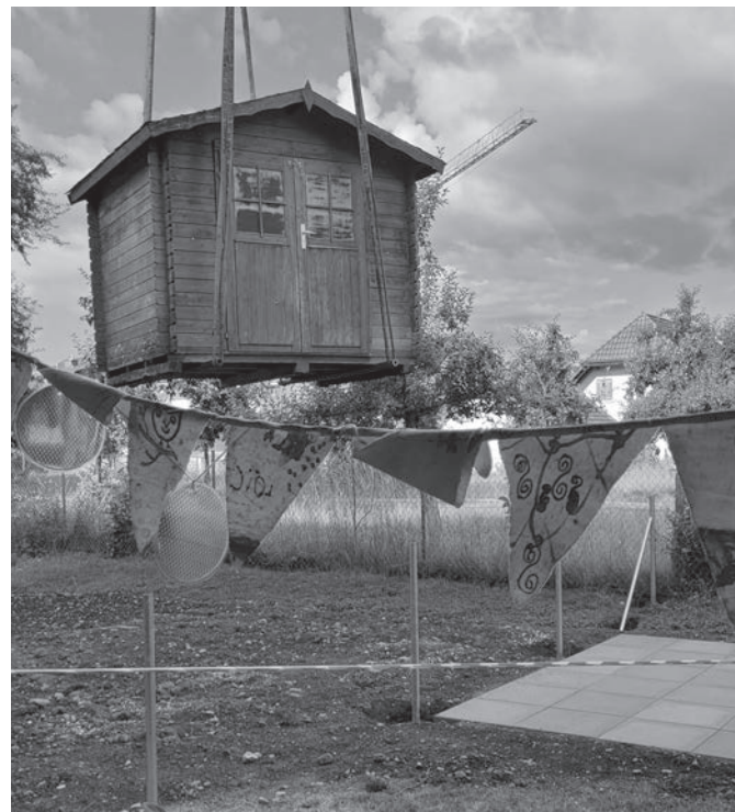
Versetzung des Gartenhauses mit dem Kran.
