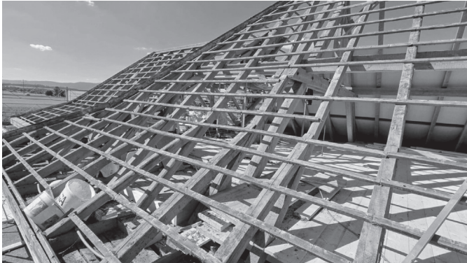
Dachsanierung im Schützenhaus.
